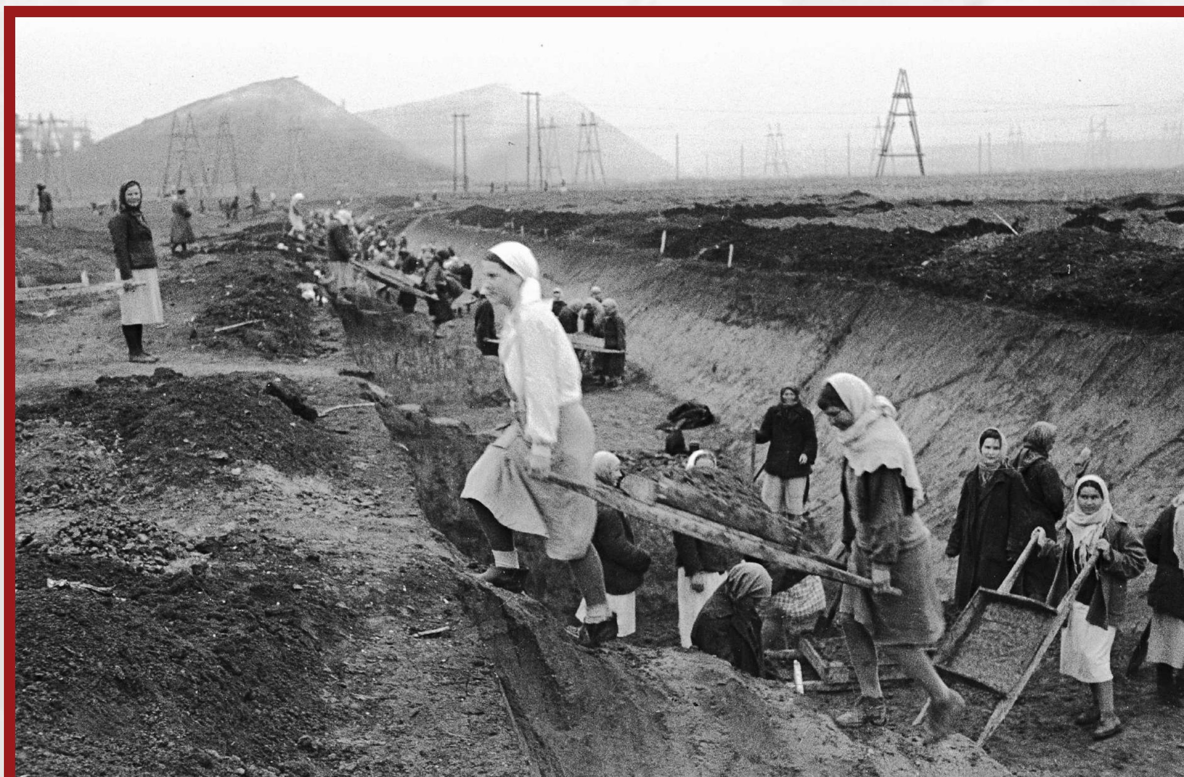
Строительство противотанковых рвов в районе Донбасса.
